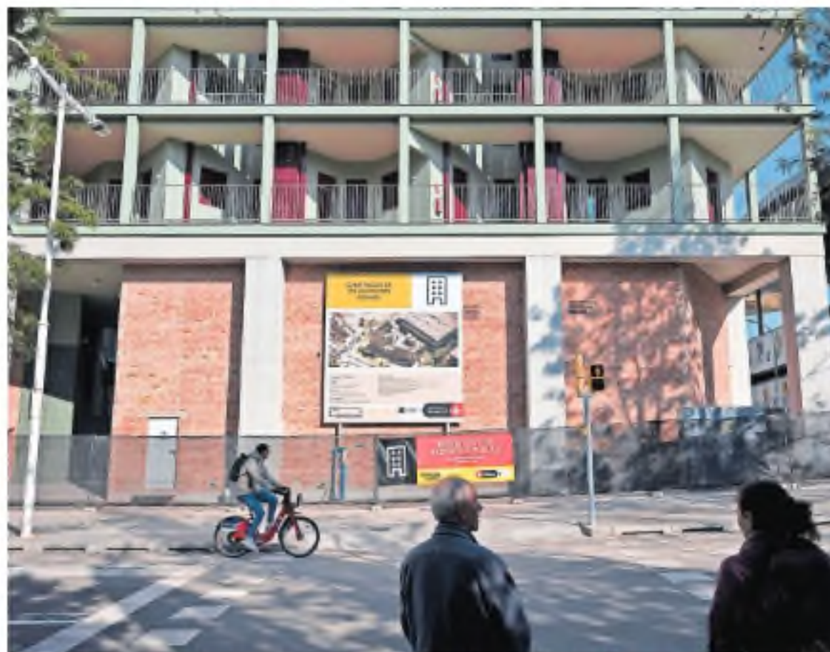
Bloque de vivienda pública en construcción, en Glòries (Barcelona), el día 2. GIANLUCA BATTISTA
